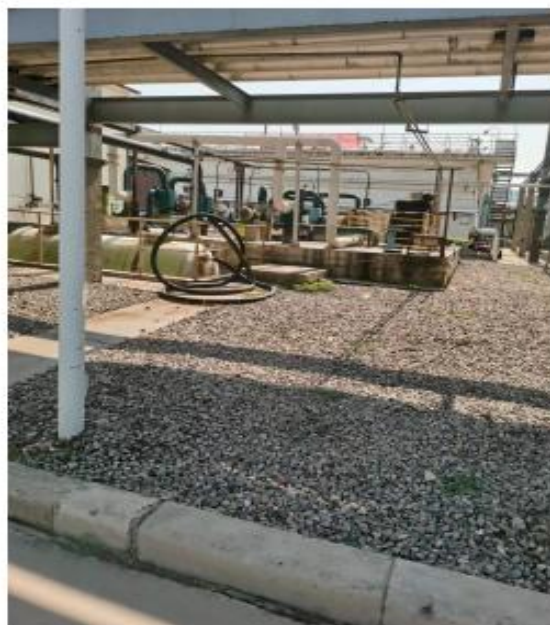
厂区污水处理厂
