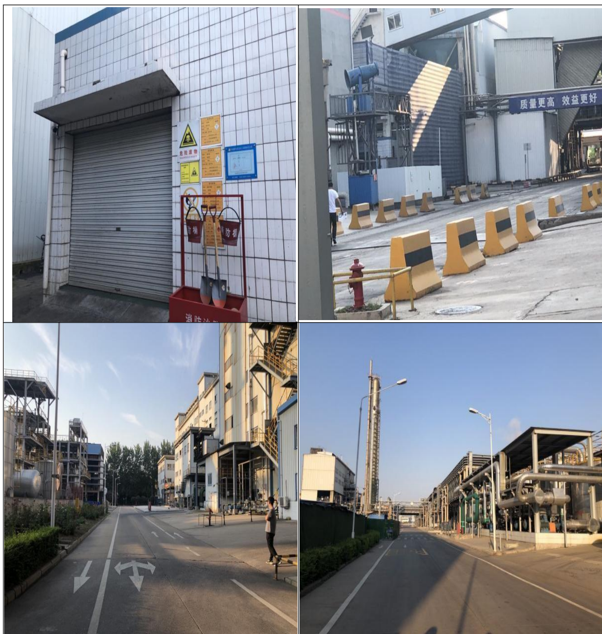
道路硬化、厂房密闭现场图
